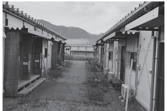
室南出口仮設団地
